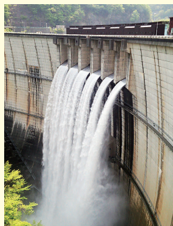
川治ダム 地上60mのキャットウォークでダムの大きさを実感
